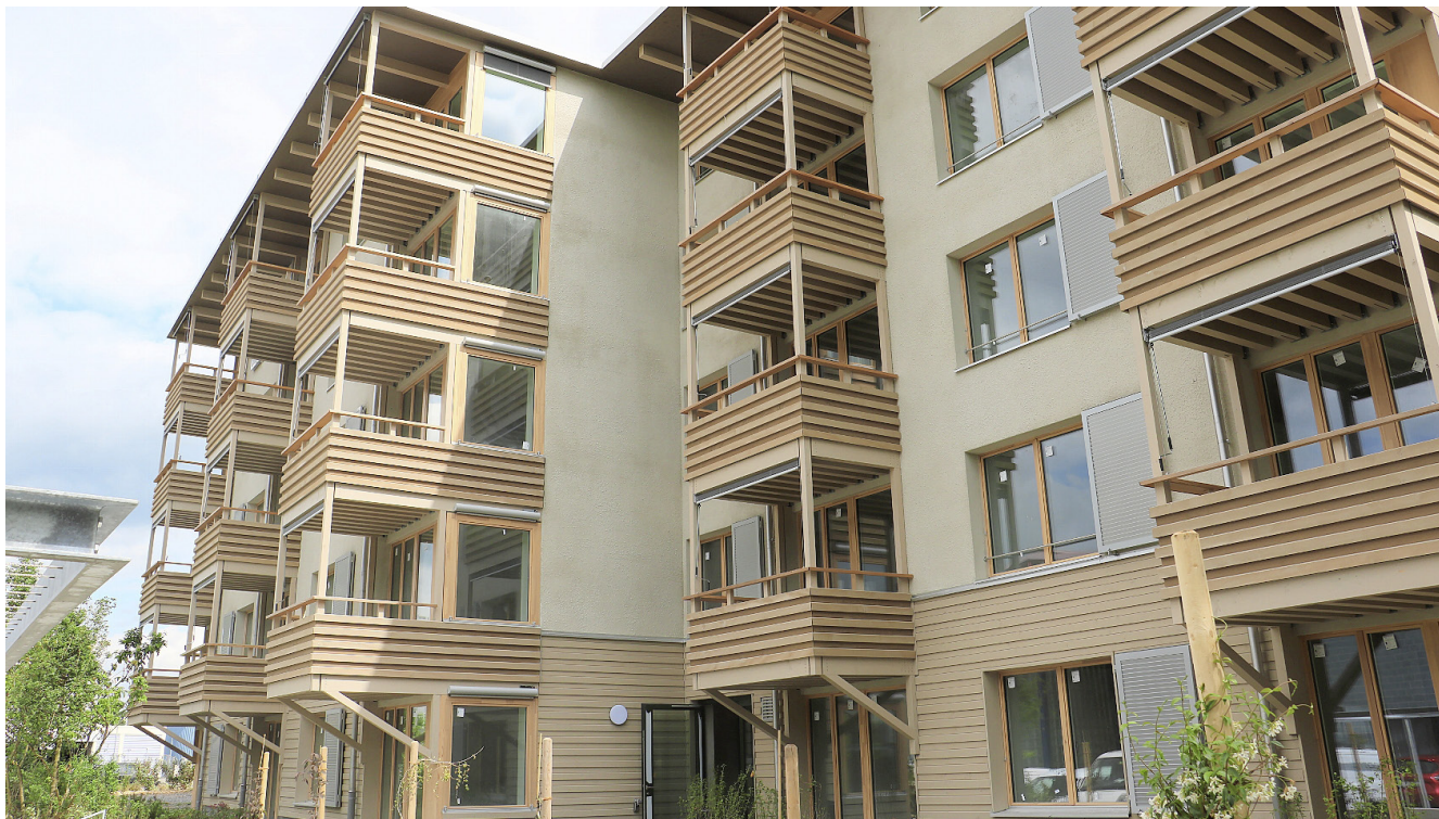
Alle Balkone der Liegenschaft an der Freihofstrasse sind auf den Zürichsee ausgerichtet.
